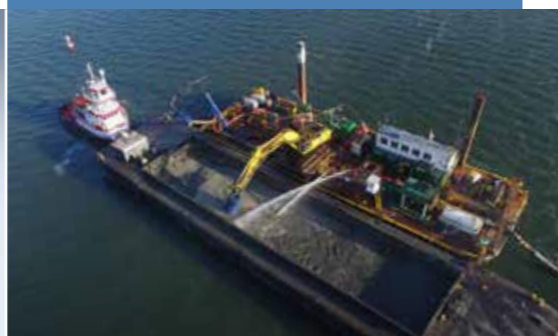
ESVAZIAMENTO DE BARCAÇAS DRAGAGEM DE MANUTENÇÃO
