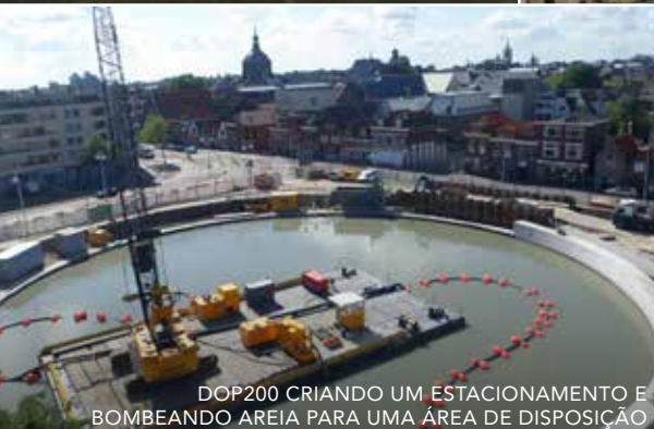
DOP250 Aprofundamento do Porto Utilizando o Desagregador
